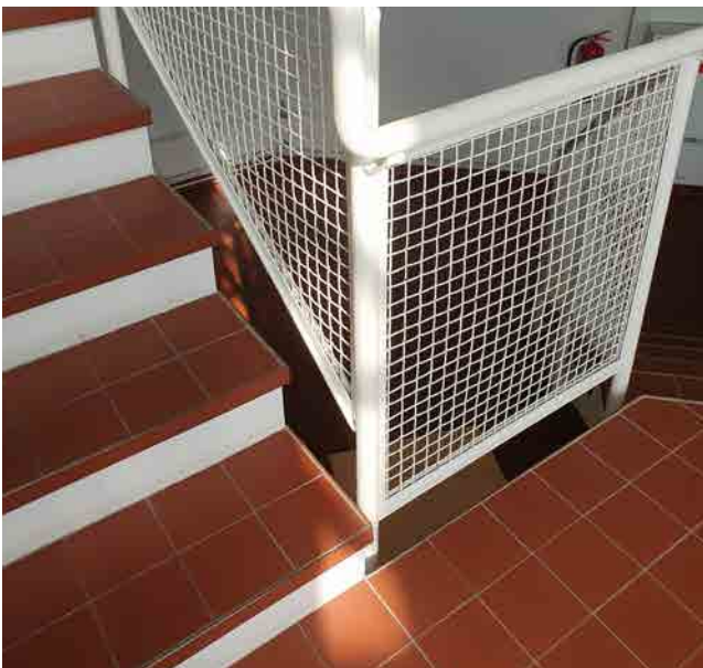
Kuva 287: Tiililaattapintaisten porrasaskelmien reuna on viimeistelty tiilenpunaiseksi maalatuilla metallilistoilla.
