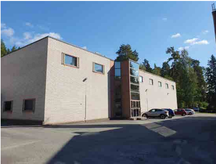
Kuva 238: Oppilaitoksen lisärakennuksen lounaisjulkisivu ja pääsisäänkäynti.
