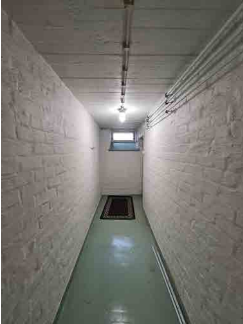
Kuva 218: Kuvassa kellarikerroksen käytävä. Tiiliseinät ja betonirakenteinen katto on maalattu valkoiseksi, betonilattia on maalattu harmaaksi.
