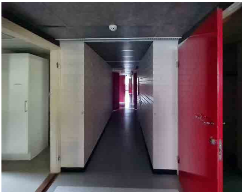
Kuva 256: Asuntolan käytävien seinät ovat valkoiseksi maalattua tiiltä, lattiat muovimattoja ja alakaton pinta akustoivaa alakattopaneelia. Lattian reunoja koristaa kiiltävän musta muovinen jalkalista. Asuinhuoneiden ovet ovat kirkkaan punaisia. Käytävät näyttävät kapeilta käytävän päädyn levennyksestä toiseen päätyyn päin katsottuna. Käytävät kuitenkin levenevät asuinhuoneiden sisäänkäyntien kohdalla, missä ovet mahtuvat hyvin aukeamaan.
