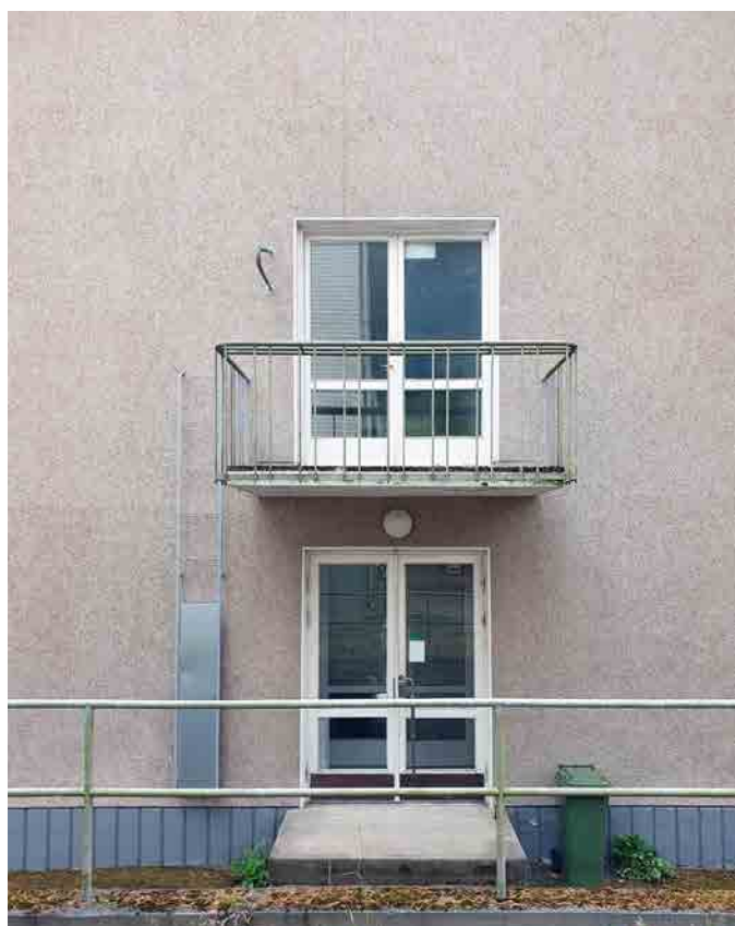
Kuva 187: Asuntola 1:n pohjoispäädyn tuuletusparveke ja porraskäytävän hätäuloskäynti.
