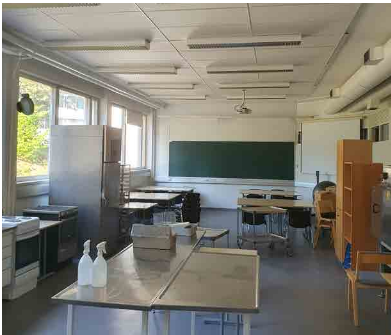
Kuva 169: Laajennuksessa sijaitseva meijeriksi suunniteltu tila, joka on 1980 -luvulla muutettu luokahuoneeksi. Samalla raken- nettiin kuvan oikeassa reunassa oleva väliseinä, joka rajaa toiselle puolelle käytävätilan.
