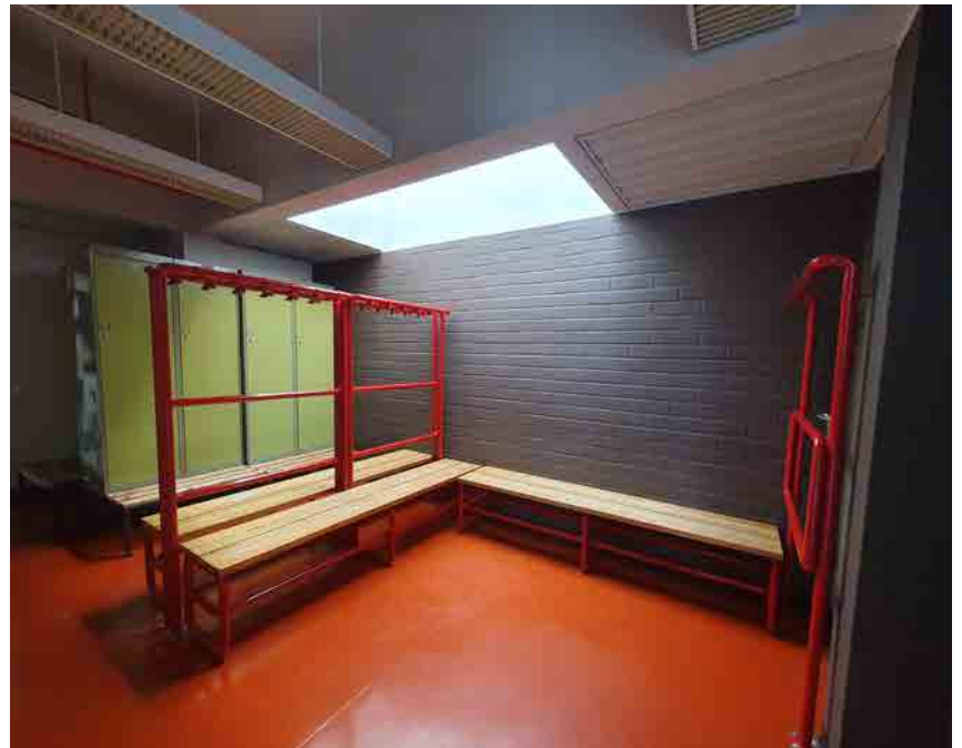
Kuva 245: Pukuhuonetilat. Toisen kerroksen arkkitehtuurissa kattoikkunat ovat suuressa roolissa. Pukuhuonetoissa lattiapintana on punainen muovimatto.
