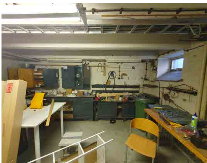
Kuva 166: Alkuperäisen koulun kellaritiloissa seinät ovat pääosin valkoiseksi maalattuja tiiliseiniä ja lattia harmaaksi maalattua betonia. Kellarin huonetiloihin johtuu hieman luonnonvaloa ikkunoiden kautta.
