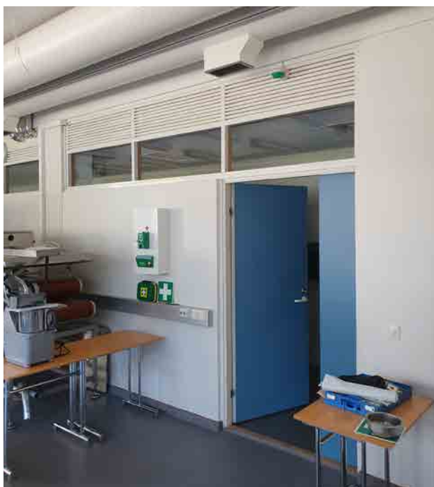
Kuva 170: Laajennuksen huonetiloissa kulkee käytä- välle avautuva yläikkuna.
