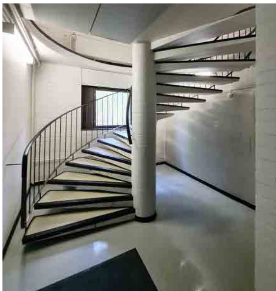
Kuva 254: Kierreporras ensimmäisestä kerrosta kuvattuna.
