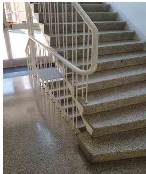
Kuva 149: Pääportaikko on betoninen ja askelmat on päällystetty mosaiikkibetonilla. Kaiteet ovat metallisia pinnakaiteita joissa on neliön mutoinen profiili. Käsijohteet ovat puiset.
