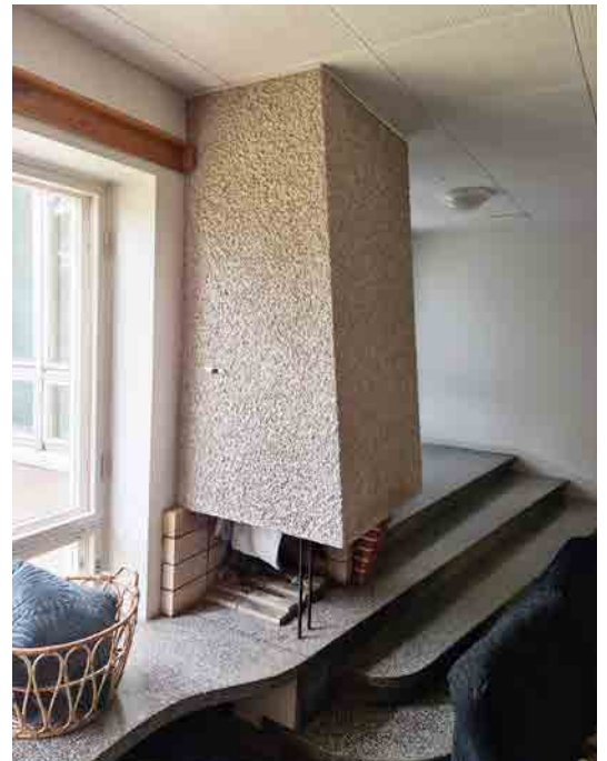
Kuva 199: Toisen kerroksen aulaan on lisätty viihtyisyyttä muun muassa arkkitehdin suunnittelemalla, tylikkäällä avotakalla, joka yhdistyy sulavasti osaksi aulan keskiosaa ja sitä ympäröiviä rakenteita. Takassa on käytetty myös julkisivuista tuttua rappauspintaa.
