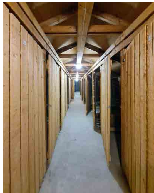
Kuva 257: Talon ullakolla sijaitsee asukkaiden irtainvarastot. Varastot on sijoitettu keskikäytävän molemmiin puolin.
