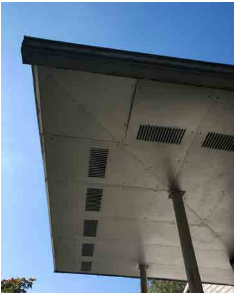
Kuva 279: Räystäiden ja katoksien alapinta on verhoiltu metallilevyllä.
