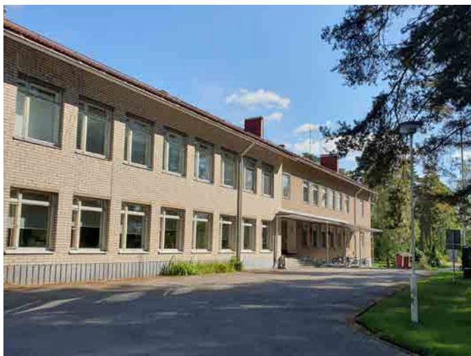
Kuva 140: Oppilaitoksen alkuperäisen osan pääjulkisivu. Vanhimman osan julkisivu on osittain rapattu ja osittain puhtaaksimuurattu.
