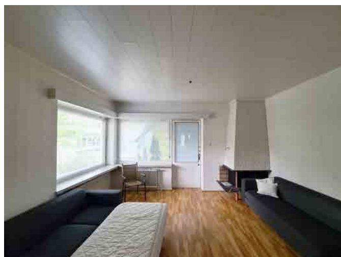
Kuva 215: Rehtorin asunnon olohuoneen nurkassa sijaitsee myös arkkitehdin suunnittelema avotakka. Takka on rakenteeltaan asuntolan takkaa kevyempi, sillä sen tukeutuminen lattiaan on täysin takan metallijalan varassa.
