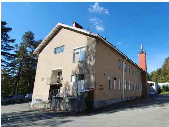
Kuva 145: Alkuperäinen koulurakennus kuvattuna idän suunnasta. Kaakkoispäädyssä näkyvä pienempi ovi ja siihen johtavat portaat lisättiin 1980 -luvulla.
