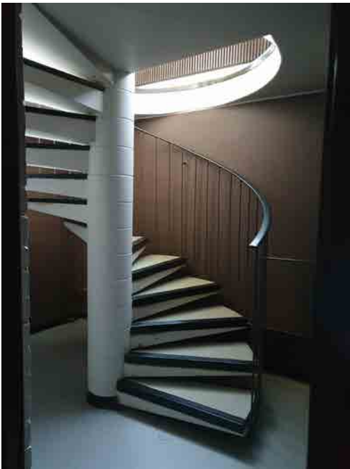
Kuva 244: Pääsisäänkäyntiä vastakkaisella puolella rakennusta kulkee kierreporras, jota pitkin pääsee yläkerran pukuhuonetoista alakerran varaston kautta liikuntasaliin.
