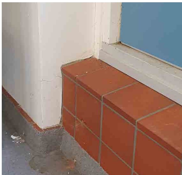
Kuva 171: Huoneen lattia oli alun perin tiililaattaa, mutta pin- noitettiin massalla 2000 -luvulla. 24 Kuvassa näkyy ulos johta- van suuren puu-lasi-parioven alareunaa ja kynnystä.
