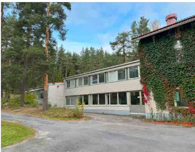
Kuva 125: Koulurakennuksen 1964 rakennettu laajennusosa.
