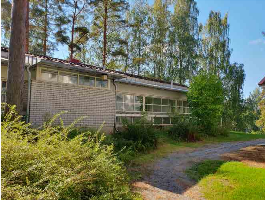
Kuva 281: Pohjoisjulkisivu. Muurauksen kohdalla sijaitsee keittosyvennys ja siivouskomero. Lasiseinä taas avautuu käytävälle.
