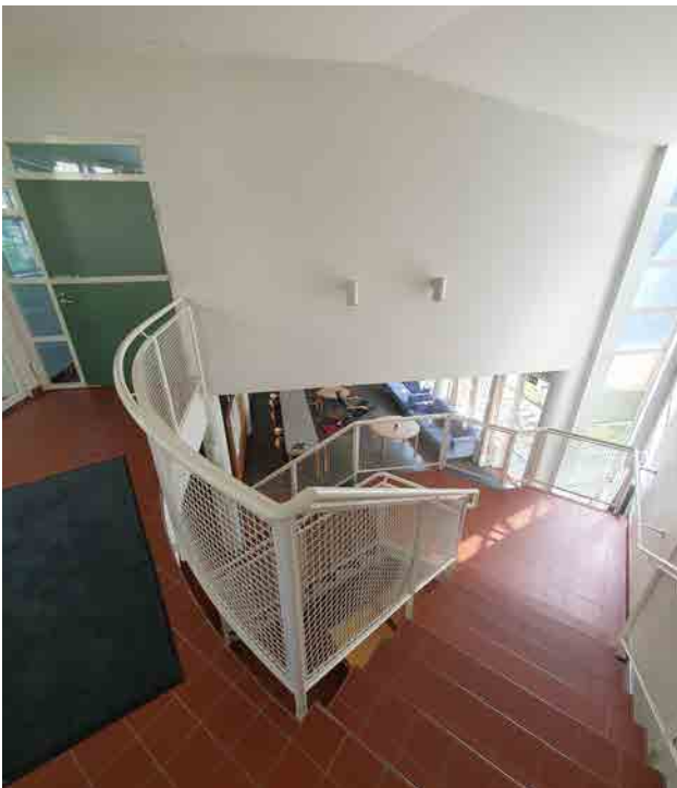
Kuva 283: Aulatilasta avautuu näkymät ulos molempiin suuntiin sekä alakerran yhteistilaan. Asuntola 4:n yleisten tilojen lattiapinnat on pääosin tiililaattaa. Kaiteet ovat valkoisia teräskaiteita. Väliovet ja keittiökalusteet ovat vihreitä.
