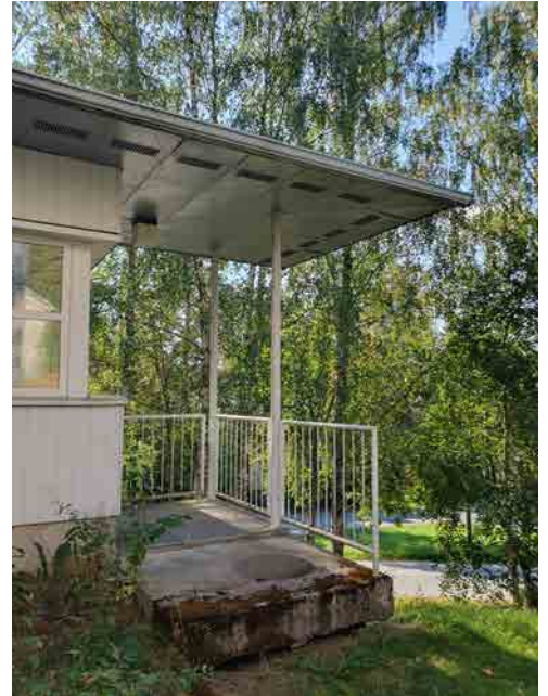
Kuva 282: Rakennuksen molemmissa päädyissä on katetut sisäänkäynnit.
