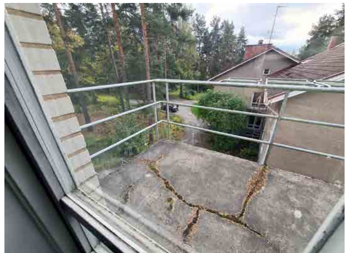
Kuva 227: Kuvassa talon eteläpäädyn tuuletusparveke. Parvekkeen kaiteet ovat olleet sirorakenteista, maalaattua teräsputkea.
