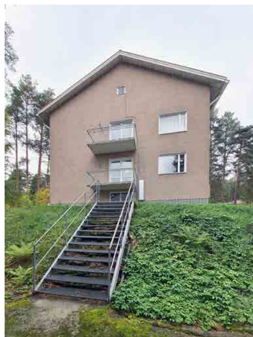
Kuva 139: Kuvassa asuntoloiden 3 ja 1 väliset ulkoportaat. Uudet teräsrakenteiset portaat ovat korvanneet alkuperäiset, huonokuntoisiksi päässeet puiset portaat, jotka on jätetty uusien portaiden alle.
