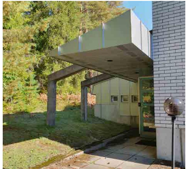
Kuva 265: Rakennuksen länsi- ja itäpäädyissä sijaitsee sisäänkäynnit, joiden suojana on tyylitellyn muotoisen betonirakenteen varassa seisova metallipintainen katos. Sisäänkäynnin vieressä on yhdyskäytävän ikkunoita muistuttavia pieniä ikkunoita.
