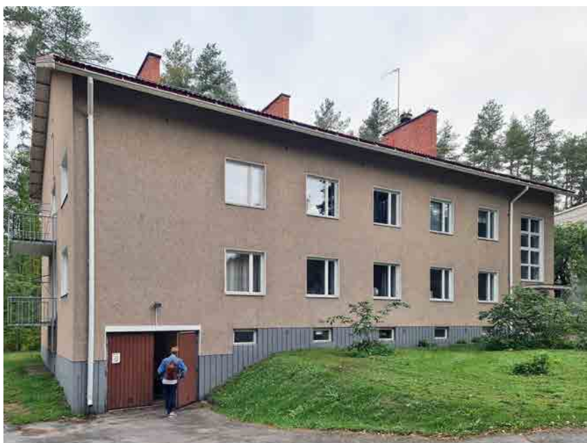
Kuva 188: Betonisokkeli laskee asuntolan eteläpuolelta maaston mukaisesti alemmas. Talon eteläpäädyssä sijaitsee myös autotalli, jossa säilytetään tällä hetkellä pihan huoltokalustoa, kuten ruohonleikkureita.
