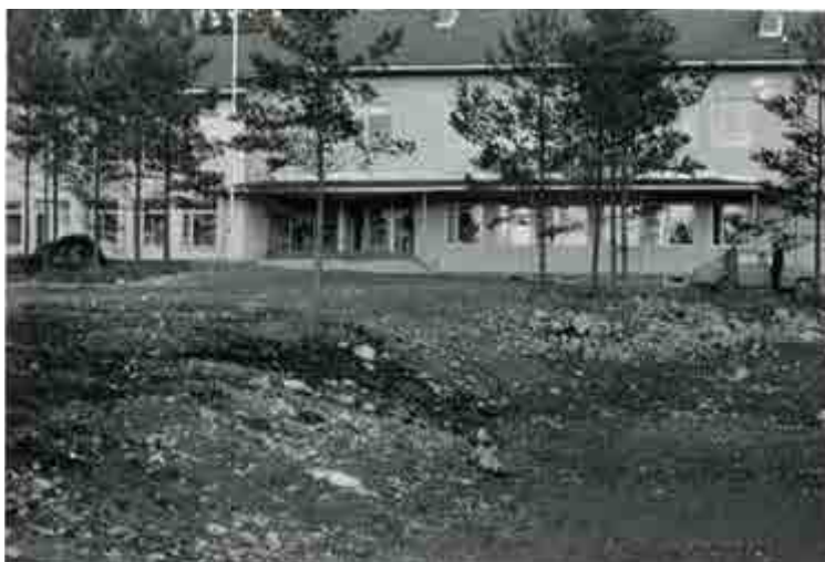
Kuva 35: Kuvassa oppilaitoksen pihan tasoitustöitä, kuva vuodelta 1955.
