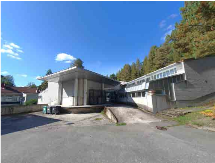
Kuva 264: Opetusmeijerin kaakkoispuolella massojen taitekohdassa sijaitsee lastauslaituri ja sisäänkäynti. Lastauslaituria ja sisäänkäyntiä suojaa näyttävän kokoinen katos.
