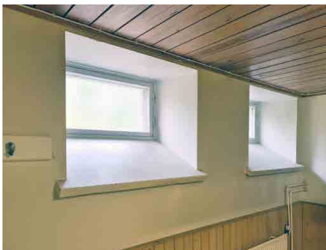
Kuva 202: Kellarin ikkunat ovat matalat ja niiden ikkuna-aukko viistoa sisäpuolelta jyrkästi alaspäin. Kuva on talon kellarin saunaosastosta.
