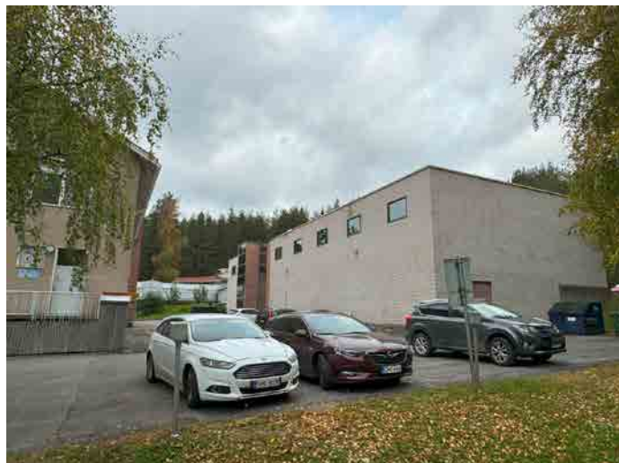
Kuva 126: Oikealla Matti K. Mäkisen suunnittelema, vuonna 1976 valmistunut oppilaitoksen lisärakennus, jossa sijaitsee muun muassa liikuntasali ja auditorio.
