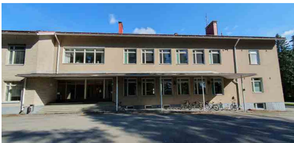
Kuva 140: Oppilaitoksen alkuperäisen osan pääjulkisivu. Vanhimman osan julkisivu on osittain rapattu ja osittain puhtaaksimuurattu.
