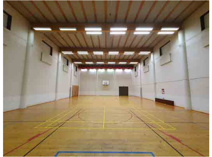
Kuva 243: Liikuntasalissa kattopalkit ovat puiset. Muualla rakennuksessa ne ovat tehty betonista. Seinien yläreunoissa on tasaisin välein sommitellut yläikkunat.
