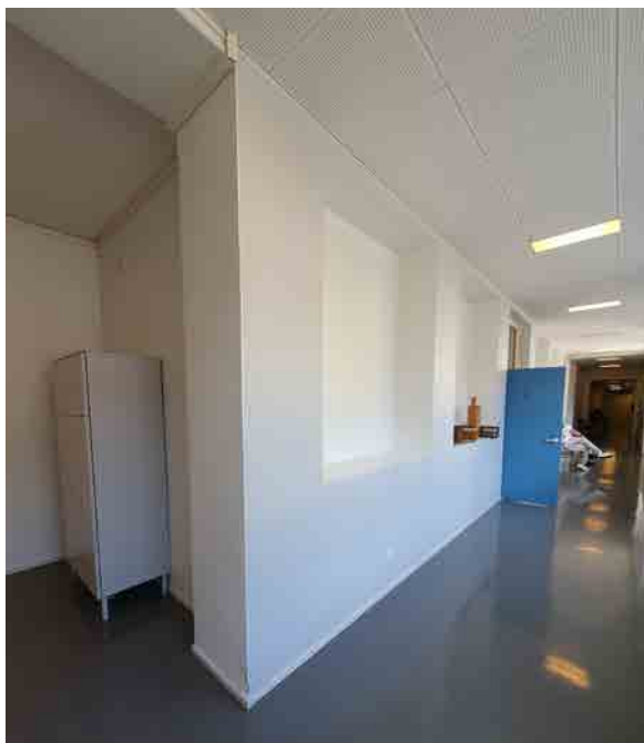
Kuva 168: 1960 -luvun laajennuksen yhteydessä toteutettu laajennussiipeen johtava käytävä ensimmäisessä kerroksessa. Kuvassa näkyy alkupe- räistä koulun ulkoseinää ja umpeen muurattuja ikkuna-aukkoja. Laajennuksessa lattiamateriaali- na on laajalti muovimatto.
