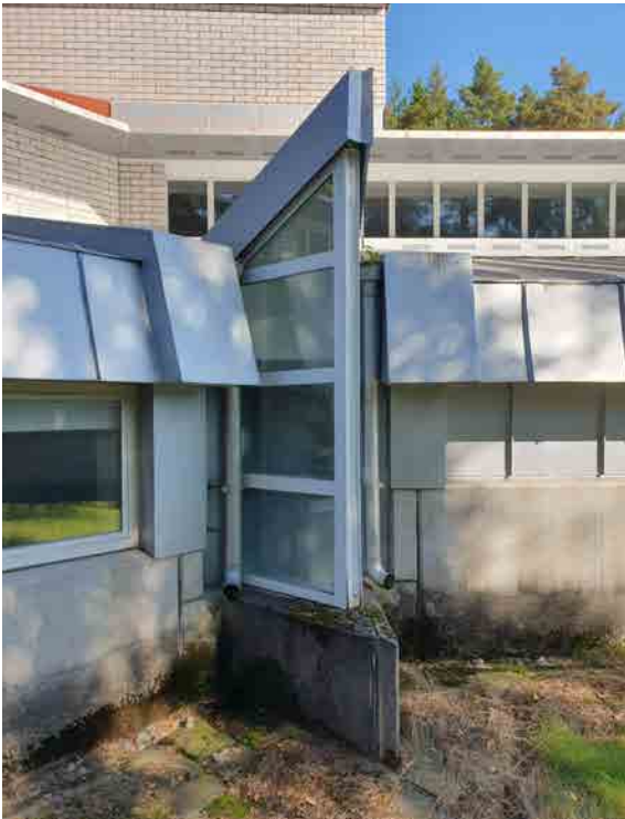
Kuva 266: Opetusmeijerin julkisivussa on massojen liittymäkohdassa eteläjulkisivulla teräs-lasirakenteinen lyhty.
