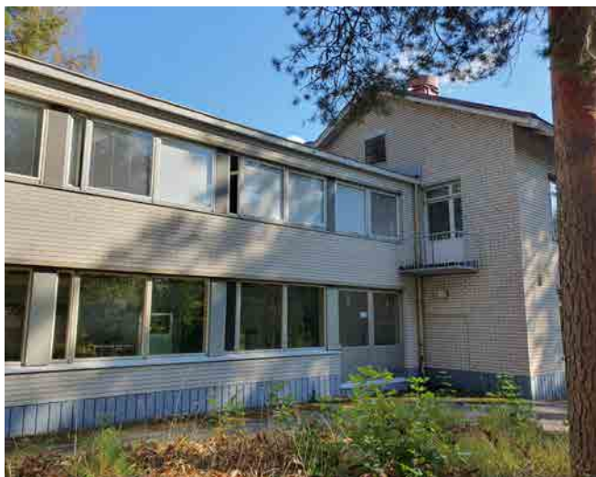
Kuva 144: Kuvassa vasemmalla olevan 1960 -luvun laajennuksen liittymäkohta oikealla olevaan alkuperäiseen koulurakennukseen. Ikkuna-aukotus muuttuu uudemmassa osassa nauhamaiseksi alkuperäisestä rytmikkäästi toistuvasta.
