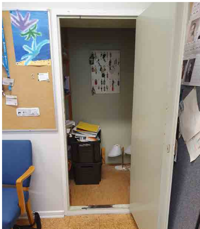
Kuva 161: Yläkerran kansliassa sijaitseva holvi ja sen alkuperäinen metalliovi.
