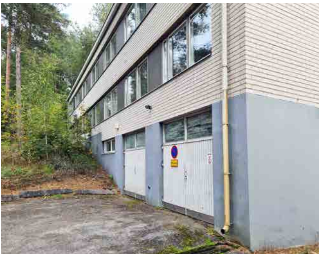
Kuva 226: Talon eteläpäädyssä länsipuolella sijaitsee autotallin ovet. Autotallit ovat olleet aiemmin oppilaitoksen henkilökunnan käytössä, mutta nykyisin niitä vuokrataan ulkopuolisille autojen säilytyspaikaksi.
