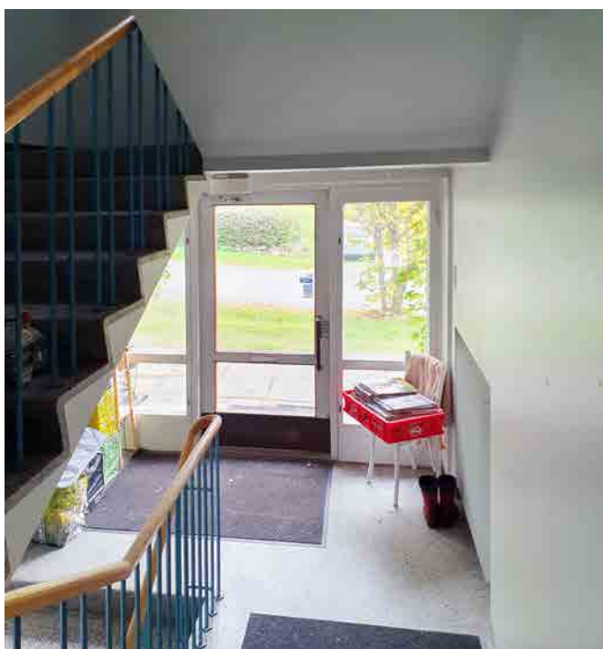
Kuva 210: Porrashuoneen pääsisäänkäynti on ensimmäisestä kerroksesta valoisa pääoven suurten lasipintojen ansiosta.
