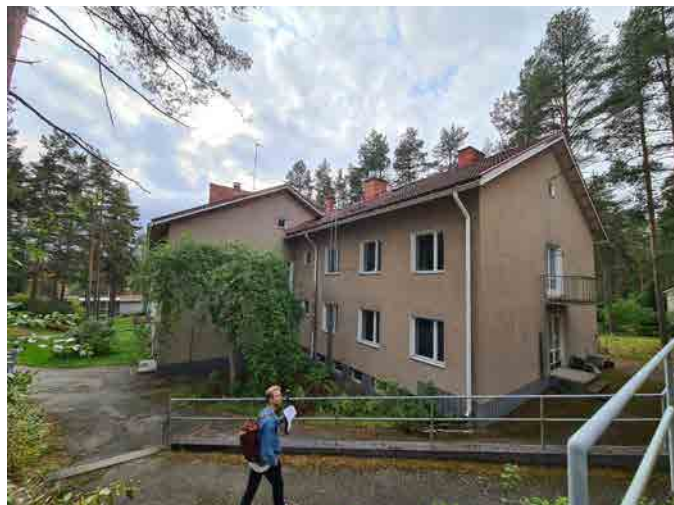
Kuva 185: Asuntola 1:n pääty asuntola 2:n ulkoportailta katsottuna.
