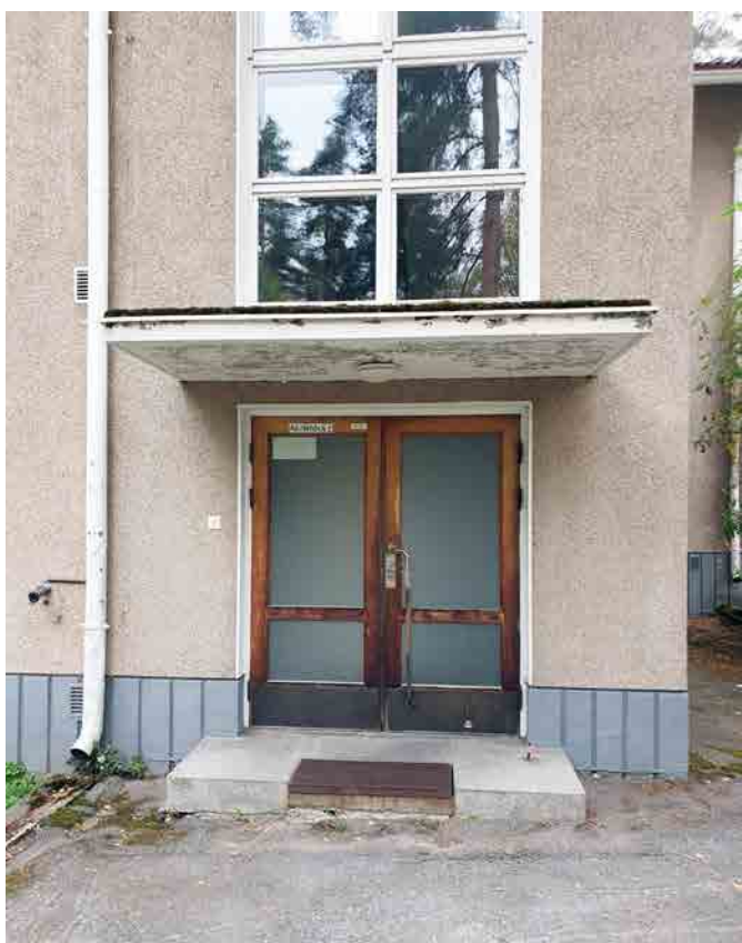
Kuva 186: Asuntolan pääsisäänkäynti ja betonirakenteinen katoslippa, jonka yläpuolella porrashuoneen korkea lasiseinä.
