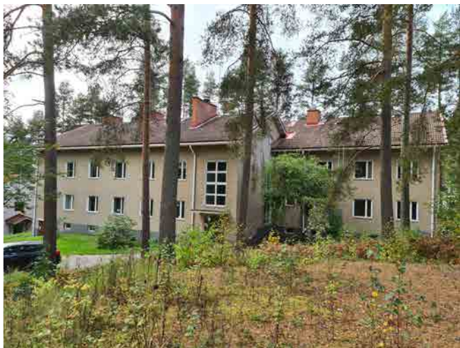
Kuva 184: Asuntola 1 sisäihan puolelta katsottuna.
