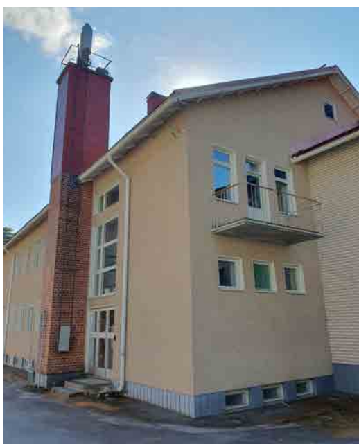
Kuva 146: Koulurakennuksen alkuperäisen osan piippu, 1970 -luvulla lisätty portaikkoon johtava sisäänkäynti ja alkuperäisen oppilaskirjaston parveke.
