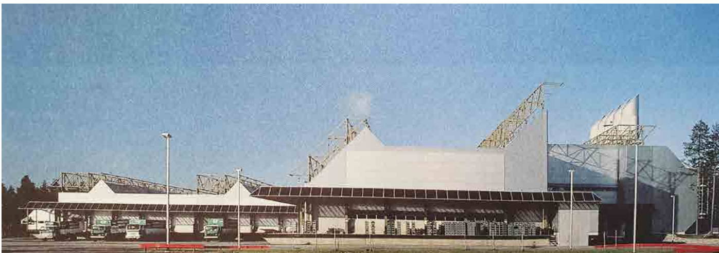
Kuva 30: Valio Oulu, Maikkulan tuotantolaitokset. Katajamäen useissa kohteissa voidaan nähdä samankaltaisia vesikaton yläpuolisia näkyviä teräsrakenteita, kuin Maikkulan laitoksessa.
