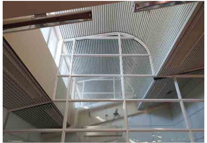
Kuva 271: Katossa kulkee rakennuksen läpi nauhamaisia kattoikkunoita, joiden kohdalla teräspoimulevystä rakennettu alakatto on paikoittain kaareva. Lasiseinät ja yläikkunat muotoilevat alakaton muotoja.
