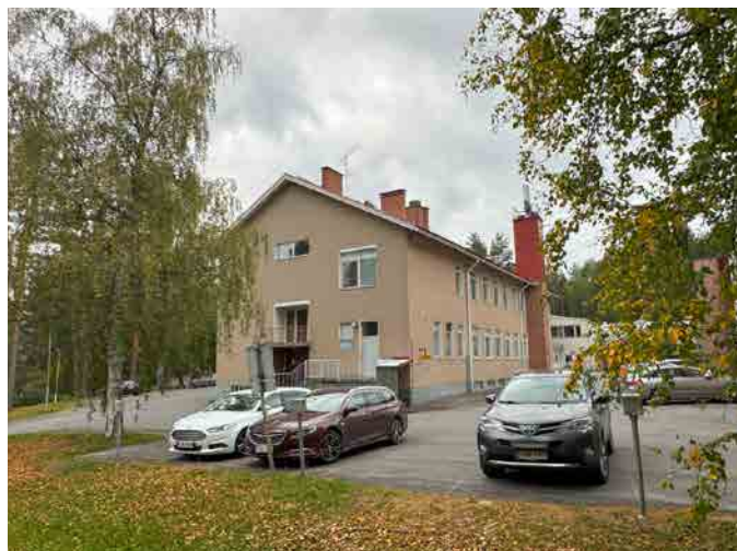
Kuva 124: Vuonna 1954 valmistunut oppilaitos kuvattuna Kankaistenkadulta, rakennuksen itäpuolelta.
