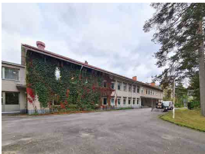
Kuva 134: Oppilaitoksen kahitilijulkisivuisessa laajennusosassa kasvava villiviiniköynnös oli kuvaushetkellä vallannut suuren osan julkisivusta rakennuksen lounaispuolella. Myöhemmin otetuissa kuvissa kyseistä villiviiniköynnöstä ei ole.
