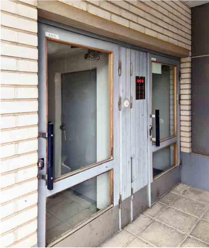
Kuva 224: 1950-luvun arkkitehtuurista myös poiketen, sisäänkäyntien tammipuiset ulko-ovet ovat aikakeudelle tyypillisesti vaihtuneet raskaisiin, teräsrakenteisiin oviin. Pienenä liittymäkohtana siirtymään 1960-luvulle, metallisten ovien lasituksia ympäröivät kehyslistat ovat näissä ovissa lakattua tammea.
