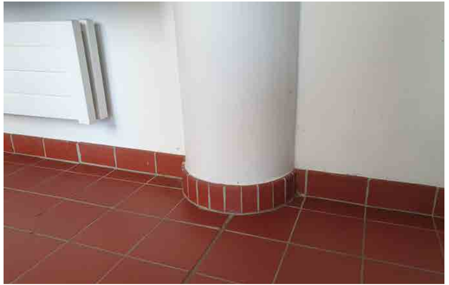
Kuva 290: 1. Kerroksessa ulkoseinustalla olevien pilarien alareuna on viimeistely tiililaatoituksella.
