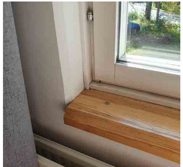
Kuva 292: Asuinhuoneiden ikkunat ja ikkunapenkit ovat puisia. Ikkunapenkkien etureuna on viistetty.
