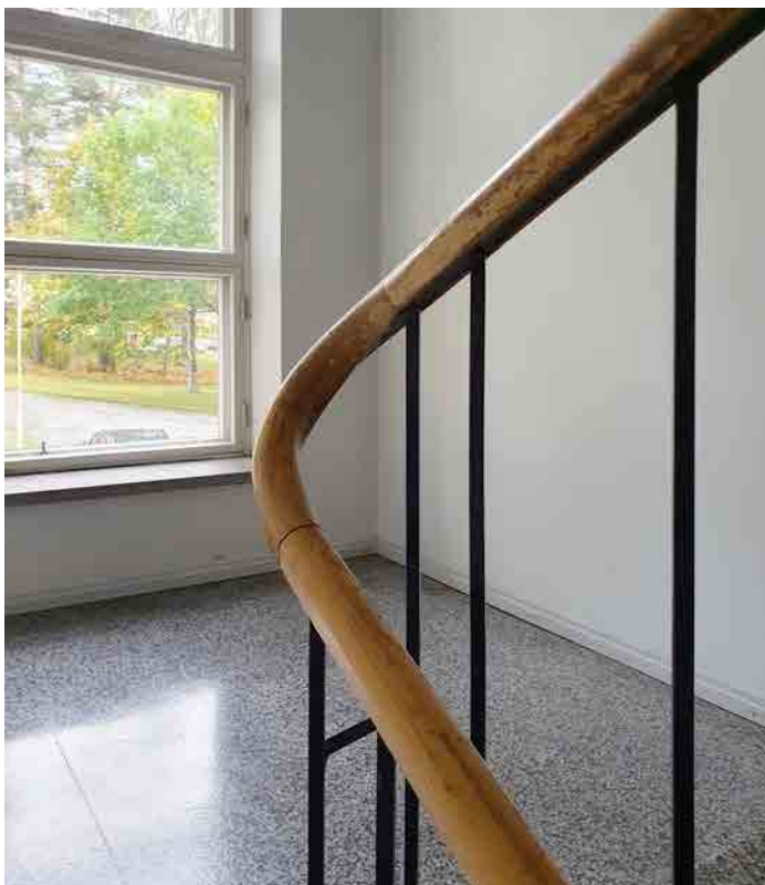
Kuva 193: Porrashuoneen käsijohde ja kaide edustavat tyyppillistä 1950-luvun siroa ja tyylikästä muotoilua. Askelmat ja välitasot ovat myös tyyppilliseen tapaan mosaiikkibetonipintaiset.
