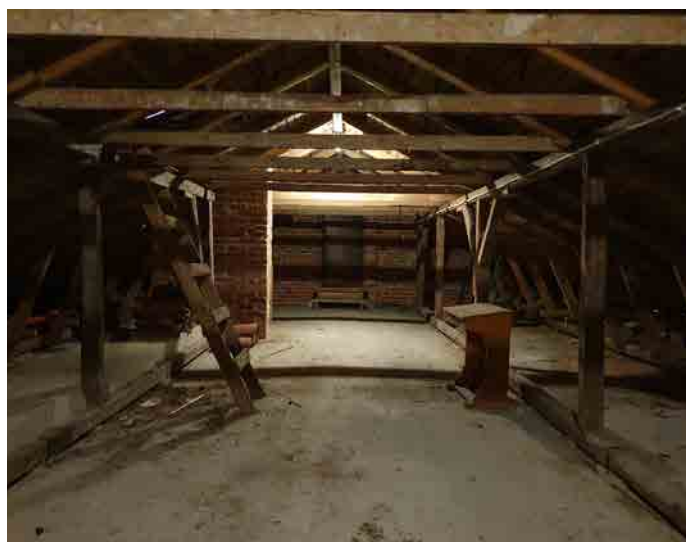
Kuva 167: Alkuperäisen koulun ullakko on tilava ja siellä sijaitsee nykyään IV-konehuone. Alkuperäiseen paisuntasäiliöhuoneeseen on sijoitettu kiinteistön tietoteknisiä järjestelmiä.
