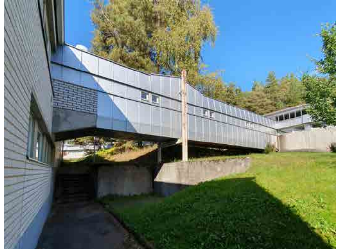
Kuva 263: Opetusmeijerin ja oppilaitoksen 1960 -luvun laajennuksen välinen yhdyskäytävä. Yhdyskäytävän osalta julkisivu on toteutettu lähes puhtaasti metallipintana. Yhdyskäytävän pikkuruiset ikkunat ovat tyypillinen 1980 -luvun postmodernismin piirre.
