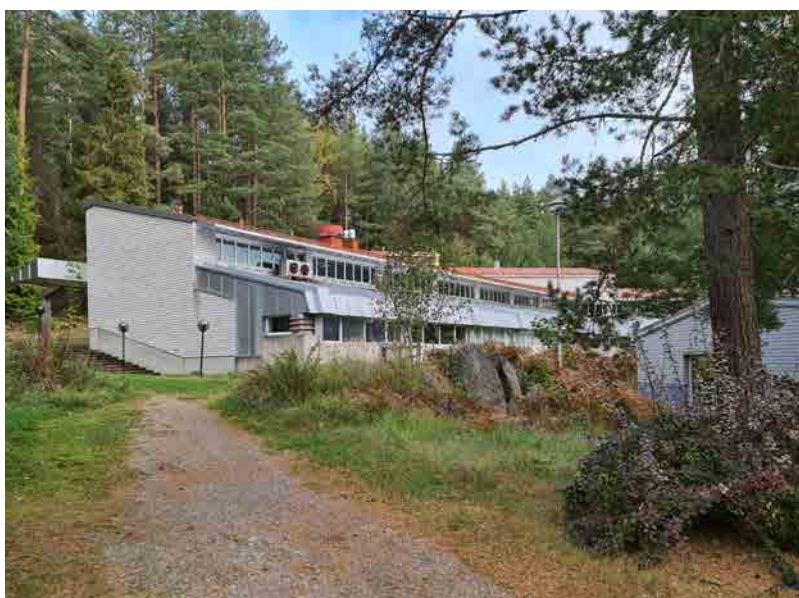
Kuva 131: Kuvassa vuonna 1985 valmistunut Opetusmeijeri asuntola 2:n vierestä, lounaan puolelta kuvattuna.
