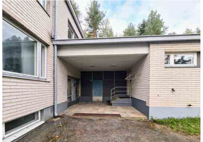
Kuva 221: Rakennuksen siipien liitoskohdassa sijaitsee suuren katoksen alla asuntolan pääsisäänkäynti.
