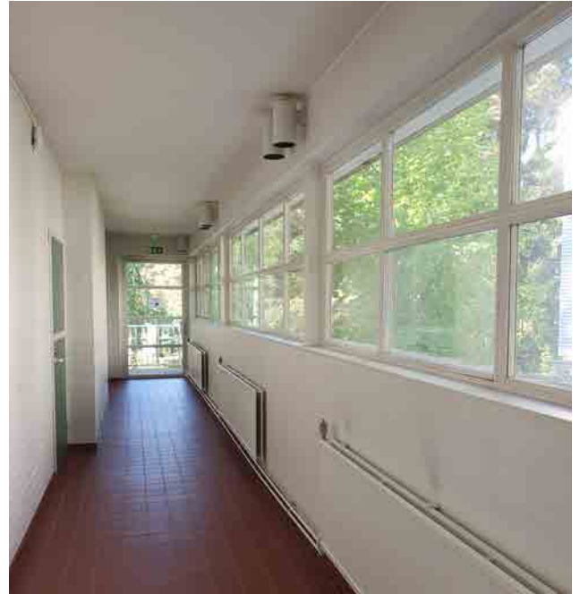
Kuva 286: 2. Kerroksen käytävien ulkoseinällä kulkee näyttävä nauhaikkuna. Yhteistilojen ikkunat ovat metallirakenteisia.
