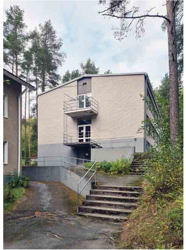
Kuva 225: Asuntolan eteläpäädyssä sijaitsee keski-käytävien hätäuloskäynnit sekä tuuletusparvekkeet. Kuvassa näkyy myös hyvin asuntola 1:n ja asuntola 2:n keskinäiset tasoerot.
