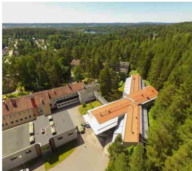
Kuva 130: Ilmakuva keskipisteenä oppilaitoksen vuonna 1985 valmistunut opetusmeijeri, josta kulkee yhdyskäytävä oppilaitoksen 1964 laajennettuun siipeen. Vasemmalla alakulmassa oppilaitoksen 1976 valmistunut lisärakennus, jossa sijaitsee muun muassa liikuntasali ja auditorio..
