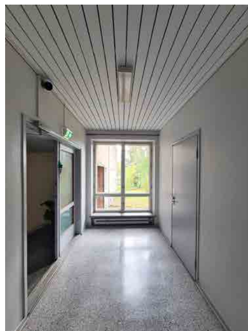
Kuva 189: Asuntolan keskikäytävää talon keskiosasta.
