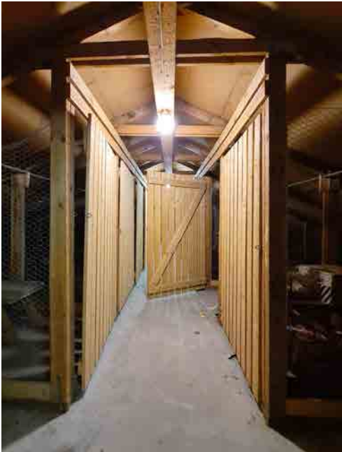
Kuva 258: Kuva talon ullakolta.
