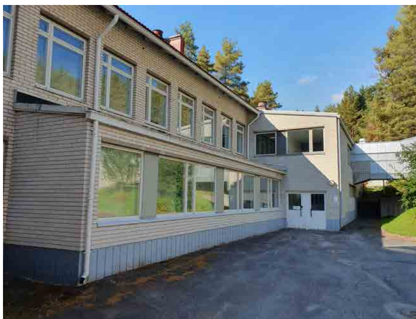
Kuva 147: Koulurakennuksen koillisjulkisivua. Kuvassa Oikeanpuoleinen sekä yksikerroksinen rakennusmassa ovat osa 60 -luvun laajennusta. Taka-alalla näkyy opetusmeijeriin johtava metallijulkisivuinen kulkusilta.
