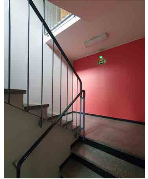
Kuva 229: Asuntolan pääporras. Askelmat ja välitasot ovat mosaiikkibetonipintaiset. Kaiteet ja käsijohteet ovat hyvin siirakenteiset ja koostuvat teräspinoista sekä mustalla muovilla päällystetystä lattateräksestä.
