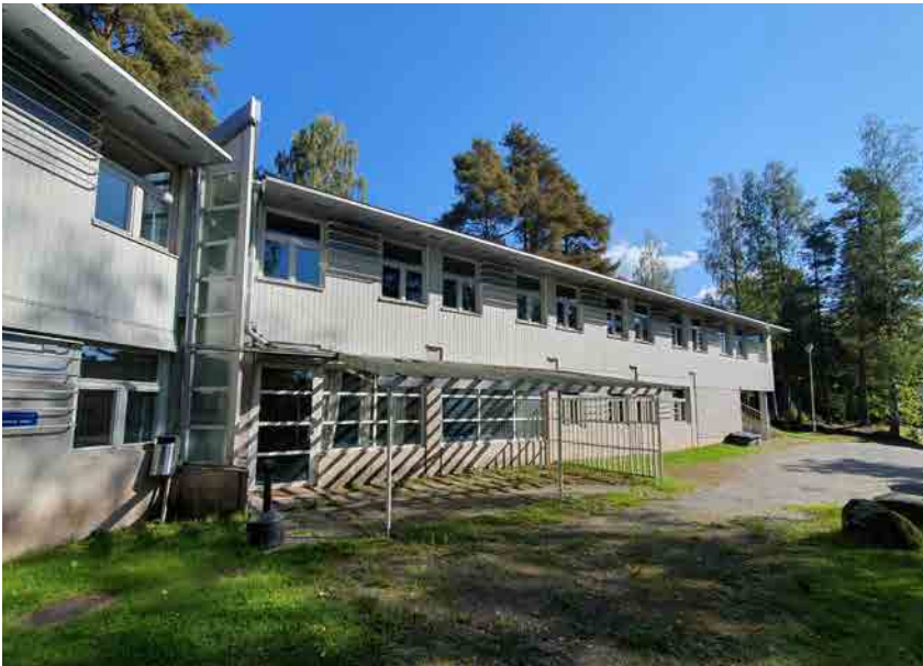
Kuva 277: Asuntola 4:n lounaisjulkisivu. 1. Kerroksessa julkisivu on osittain valkoista tiiltä ja osittain betonia. 2. Kerroksessa julkisivumateriaalina on osittain valkoinen tiili ja osittain valkoiseksi maalattu puuverhous. Rakennusmassan taitekohdassa julkisivussa on teräs-lasirakenteinen korkea lyhty. Pergolan kohdalla sijaitsevat asuntolan yhteistilat.
