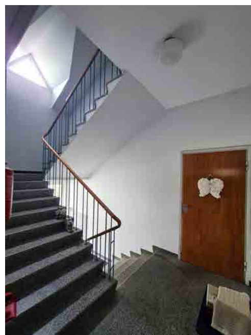
Kuva 213: Asuntola on luonteeltaan yksityisempi, kuin oppilasasuntolat. Porraskäytävä on luonteeltaan enemmän kerrostalomainen. Kulku asuntoihin käy kerrostaso-ovien kautta pitkien keskikäytävien sijaan. Porrashuoneesta pääsee asuntojen lisäksi kellariin ja ullakolle. Kolmion mallinen kattoikkuna tuo ilahduttavasti luonnonvalon kajoa porrashuoneeseen yläkautta.
