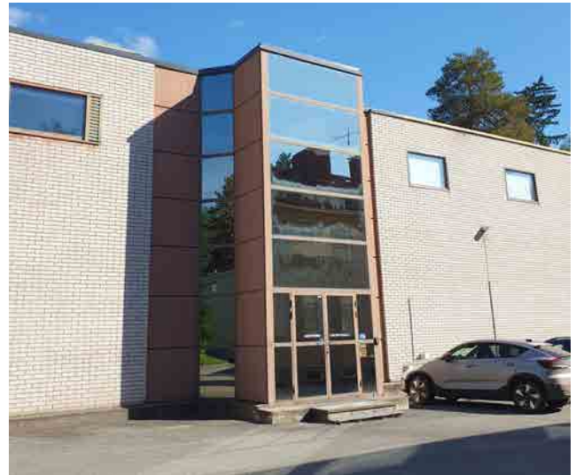
Kuva 239: Lisärakennuksen sisäänkäynnin kohdalla julkisivussa on paljon ikkunapintaa ja julkisivun materiaalina on punertava teräslevy.
