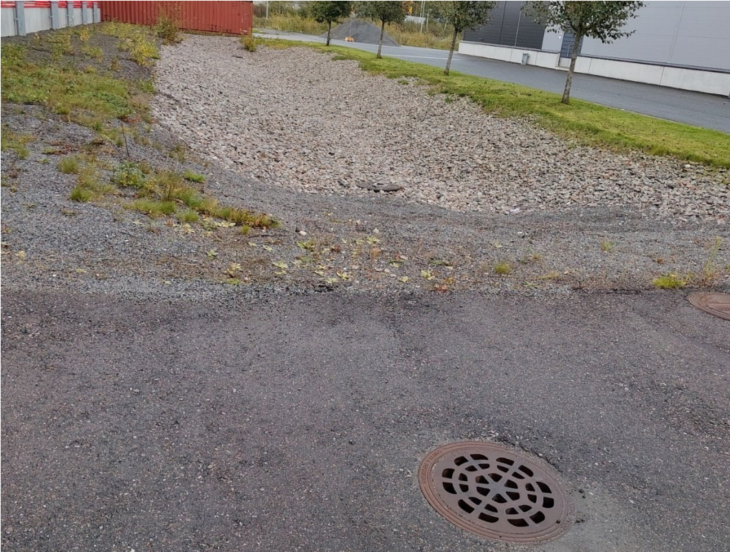
Kuva 8. Motonetin ja Prisman välissä oleva hulevesien viivytys.
