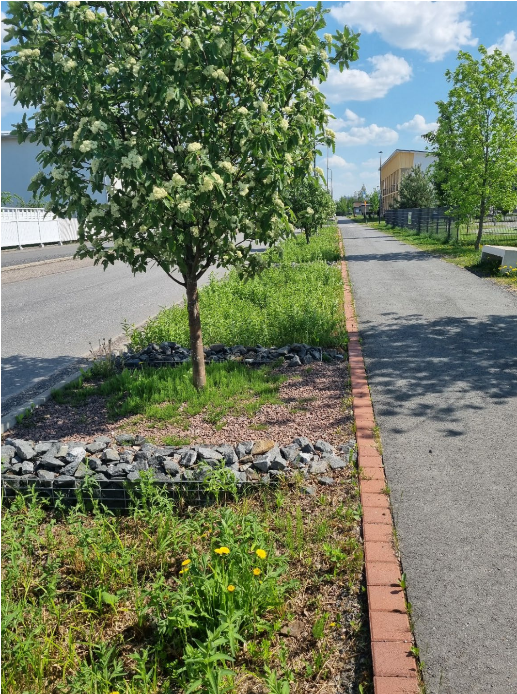
Kuva 23. Esimerkki biosuodatuspainanteesta Porissa.
