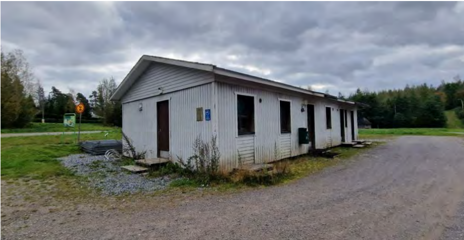
Kuva 12. Palloilukenttiä palveleva ulkorakennus.
