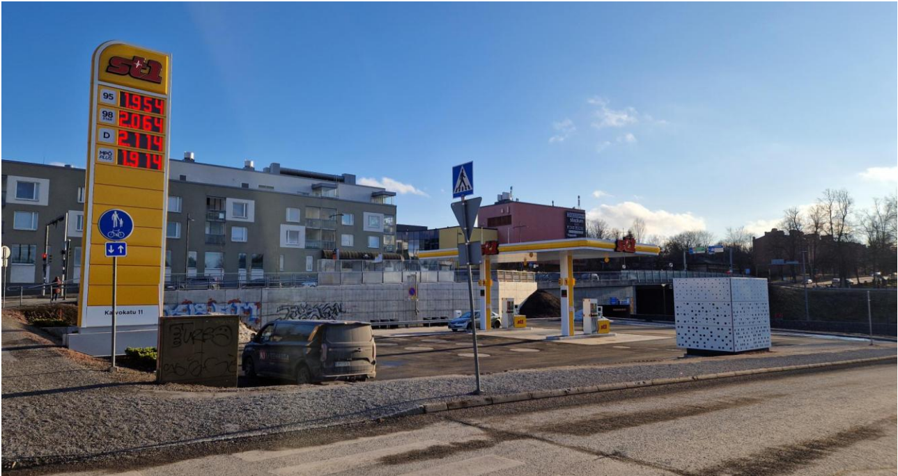
Kuva 11. Valmistunut polttoaineen jakelupiste kuvattuna Kaivokadulta Turuntien suuntaan.
