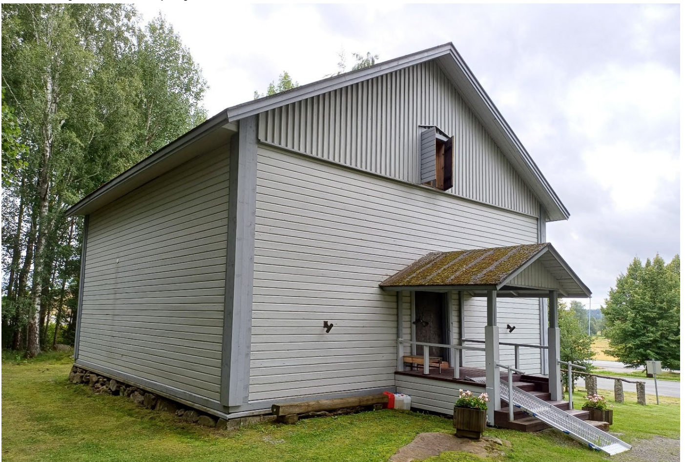
Kuvassa pitäjänmakasiinin pääjulkisivu länteen.
