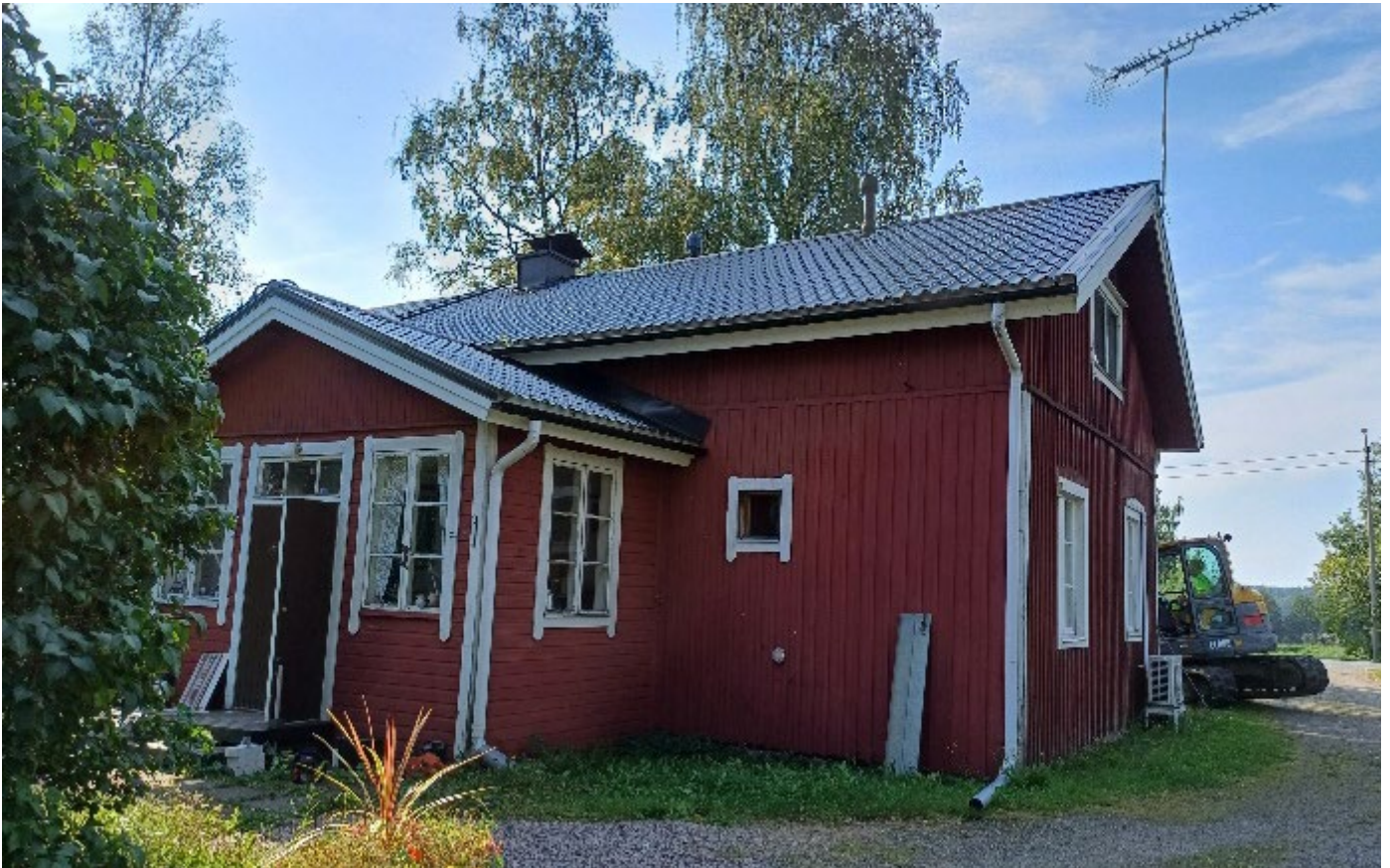
Kuvassa päärakennus kuvattuna sisäpihan puolelta pohjoisen suunnasta.
