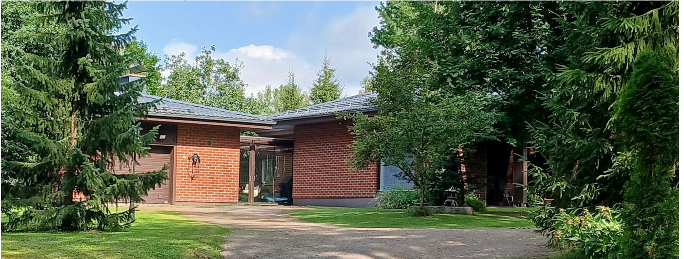
Kuvassa päärakennus kuvattuna kaakosta. Rakennuksessa lasiseinäinen väliosa.
