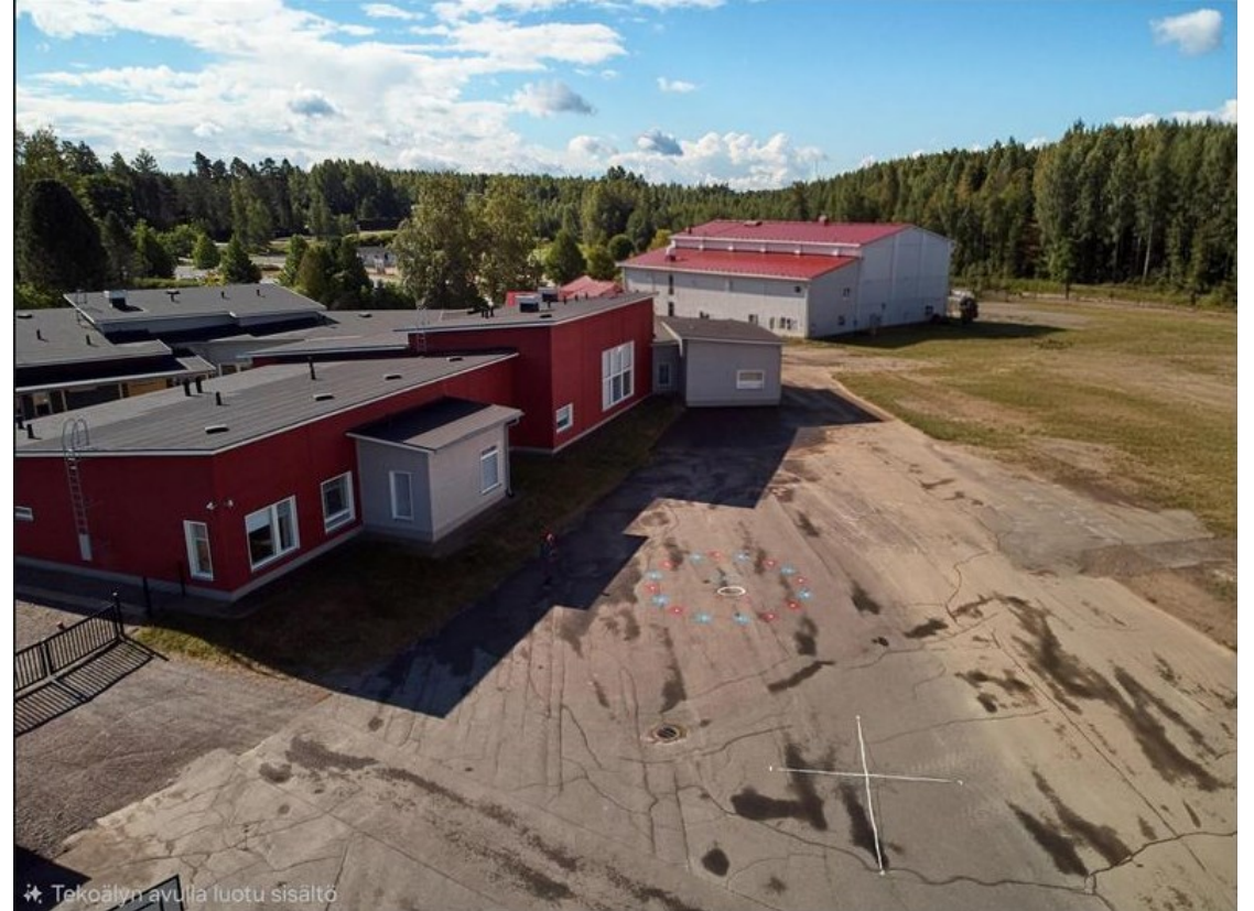
Mahdollinen maisemallinen muutos, mikäli osa koulurakennuksen osista päätetään purkaa
