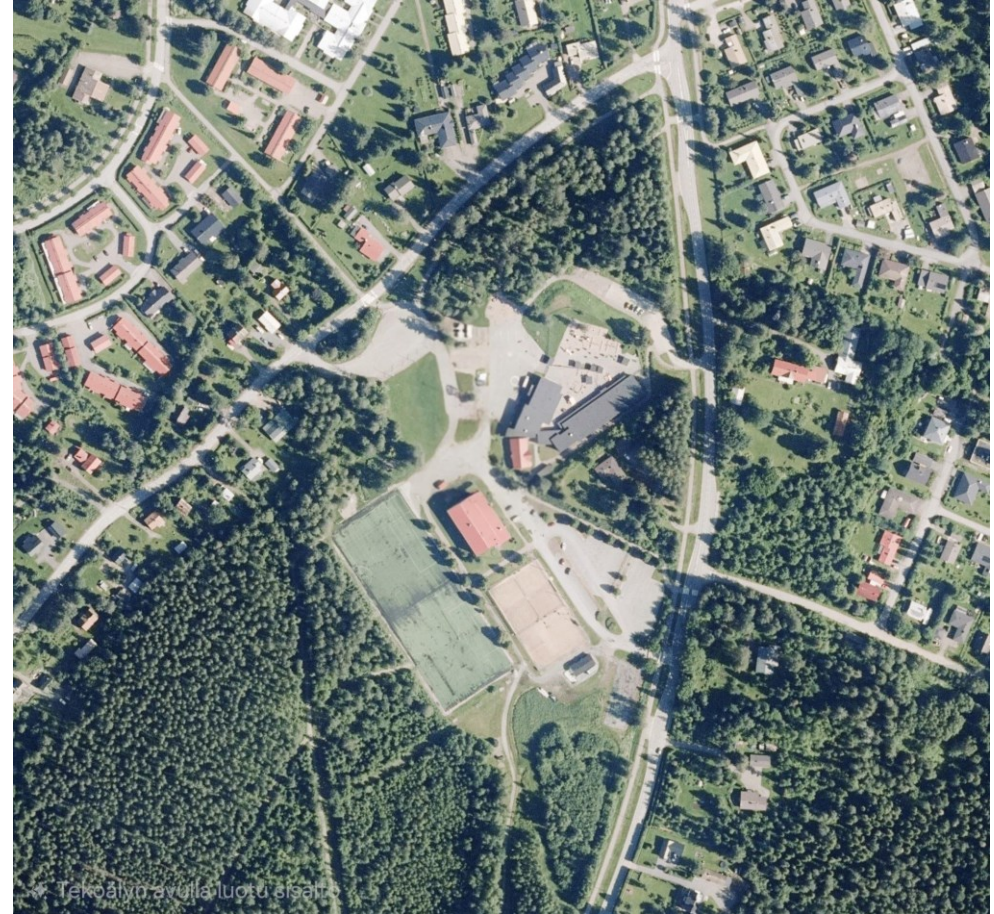
Mahdollinen maisemallinen muutos, mikäli osa koulurakennuksen osista päätetään purkaa
