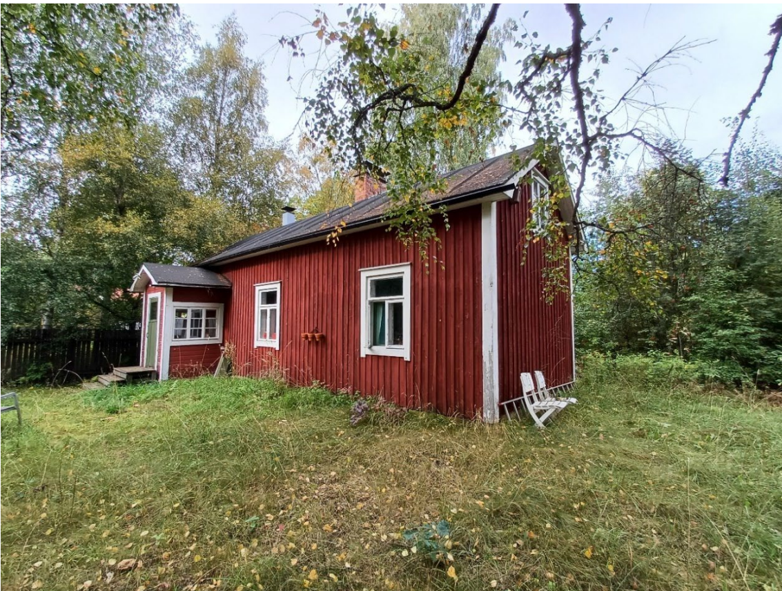
Kuva 17. Entiselle mäkitupalaisalueelle sijoittuva pieniirteinen rakennus.
