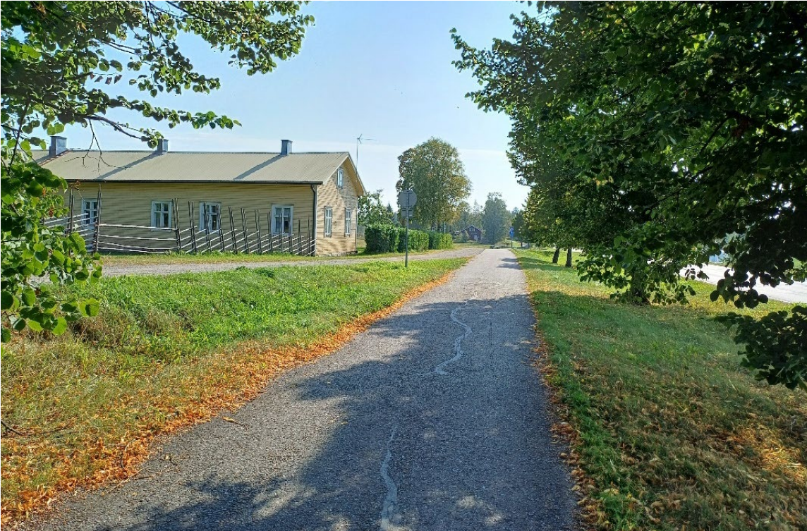
Kuva 23. Leipäläntien ja littalantien väliin sijoittuva kevyen liikenteen väylä.
