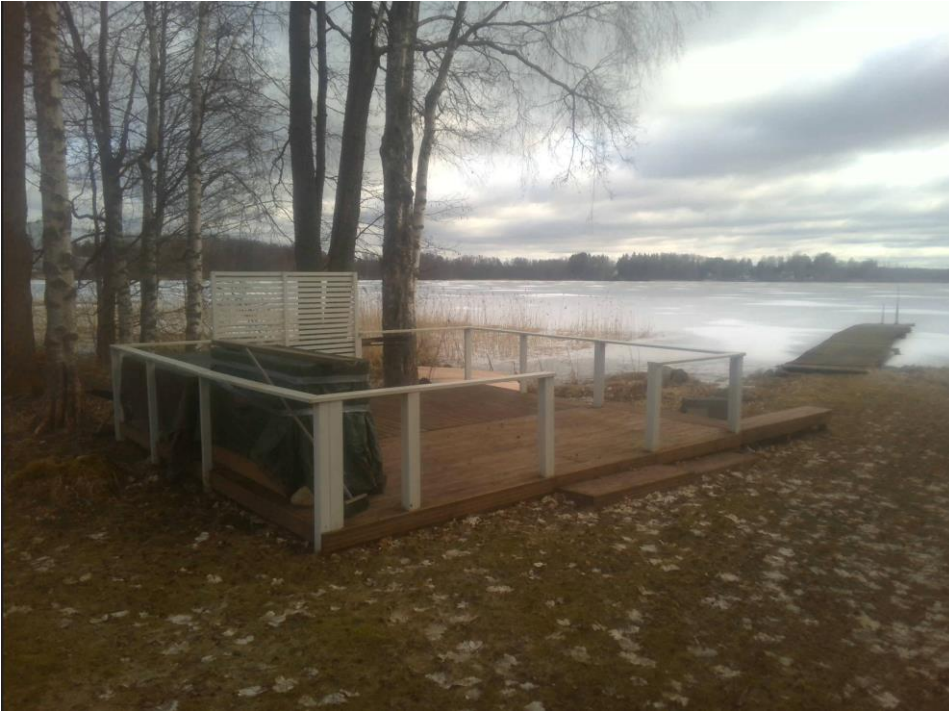
Kuva 8. Rannassa sijaitseva terassirakennelma.
