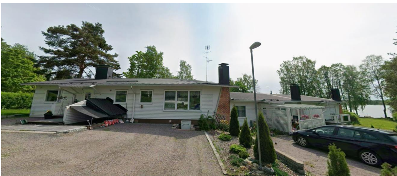
Kuva 10. Rakennuksen julkisivu. Kuva: Google.
