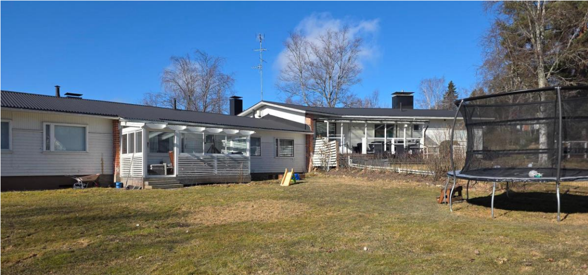
Kuva 12. Rakennuksen julkisivua takapihalta päin kuvattuna. Kuva: K. Miller 2026.
