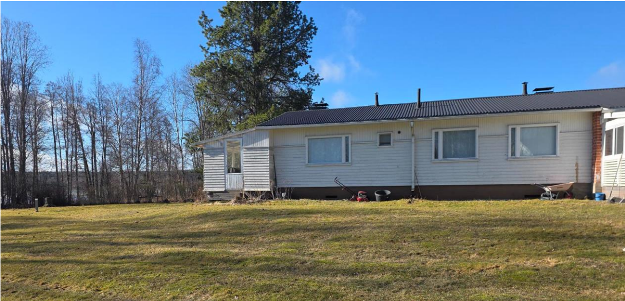
Kuva 13. Rakennuksen julkisivua takapihalta päin kuvattuna. Kuva: K. Miller 2026.
