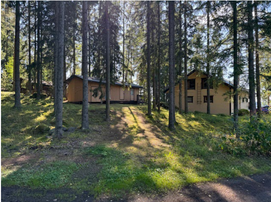
Kuva 4. Kiinteistön 109-563-2-80 pihapiiriä. Oikealla lomarakennus, vasemmalla talousrakennus.
