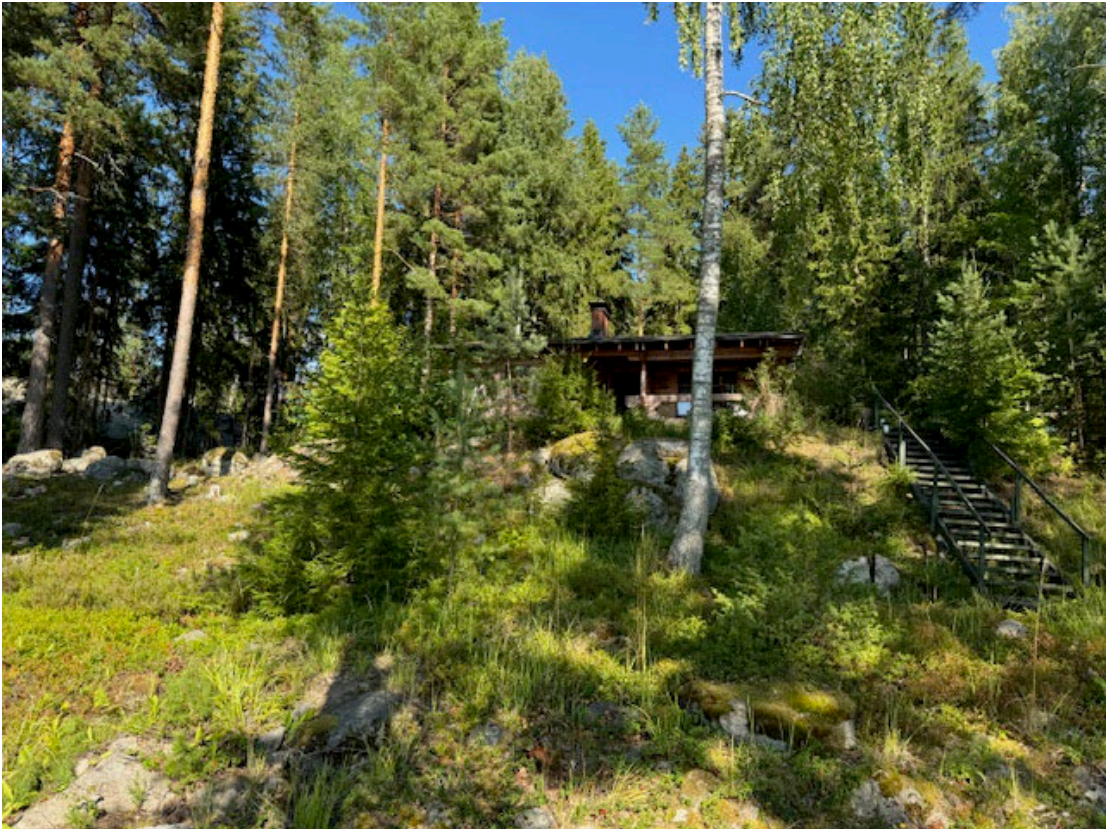
Kuva 6. Näkymä Kuohijärven rannasta kiinteistön 109-563-2-81 lomarakennusta kohti.
