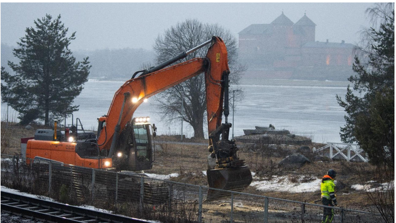
Kuva 18: Kaivinkone Sairion jätevesipumppaamon saneeraustöissä helmikuussa 2025, kuva: Sami Kyrölahti/ HS-Vesi.
