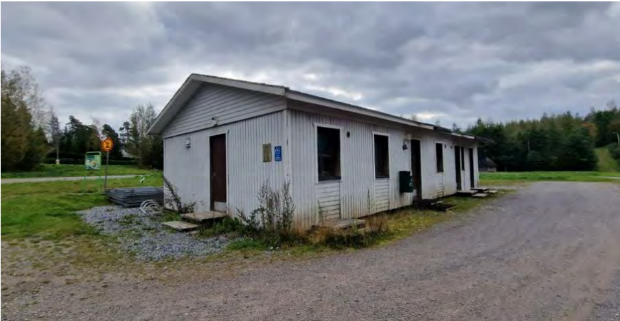
Kuva 12. Palloilukenttiä palveleva ulkorakennus.
