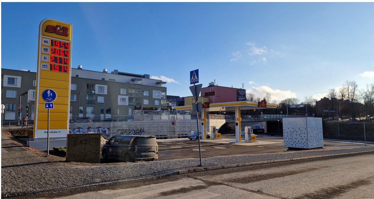
Kuva 11. Valmistunut polttoaineen jakelupiste kuvattuna Kaivokadulta Turuntien suuntaan.
