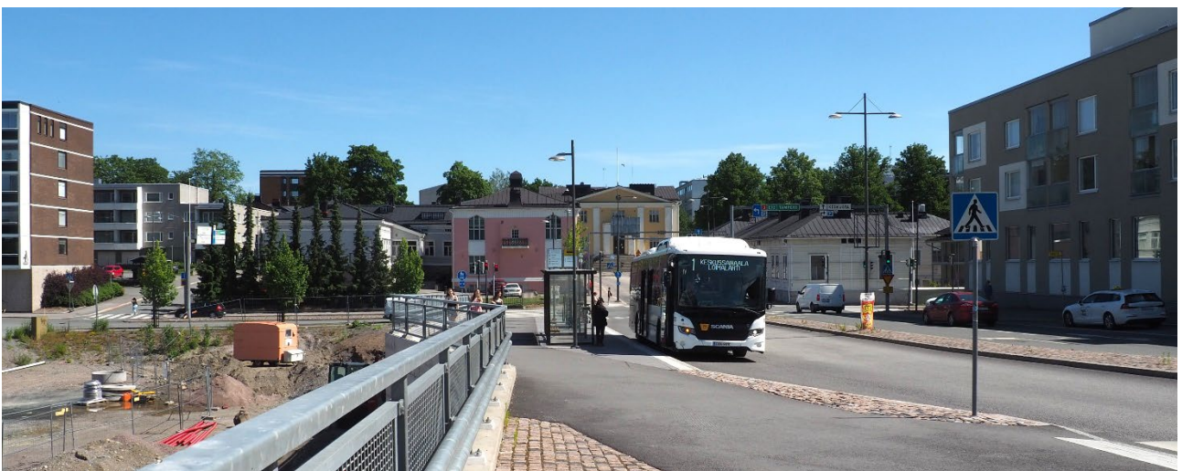
Kuva 10. Turuntien pääte ja Pikkutorin ympäristö. Vasemmalla kaava-alueeseen kuuluva polttoaineen jakelupisteen rakennustyömaa.
