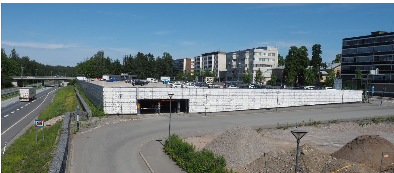
Kuva 8. Kaivoparkin pysäköintilaitos. Kuvassa etualalla kiinteistö 109-1-37-1, jolle ollaan poikkeusluvalla rakentamassa polttoaineen jakelupistettä. Taustalla kerrostalojen välissä rouvasseuran talo.
