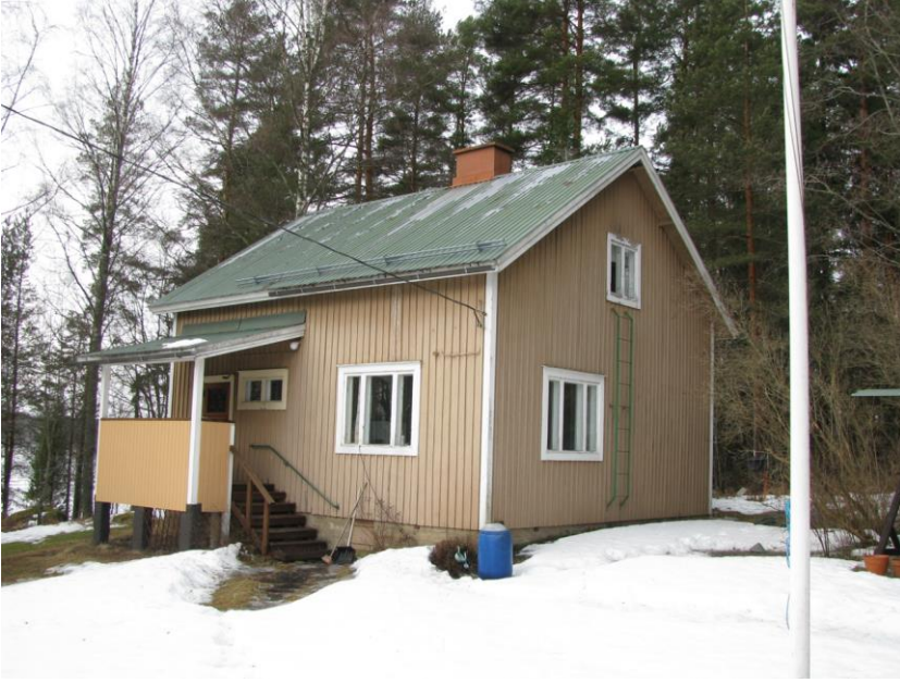
Kuva 8. Tilan Telkkä I asuinrakennus.
