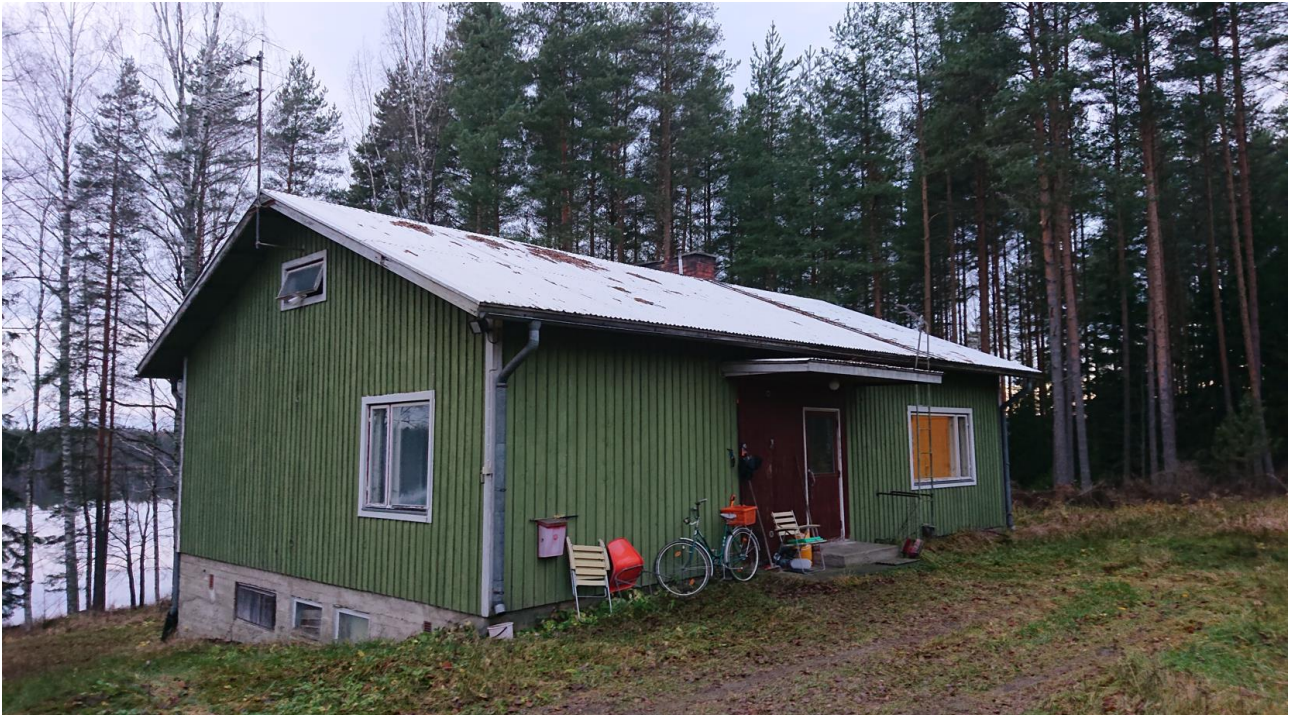
Kuva 6. Perkalahden tilakeskuksen asuinrakennus.
