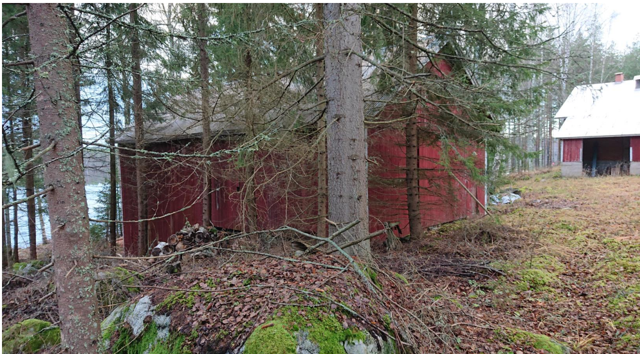
Kuva 8. Perkalahden tilakeskuksen puimalarakennus.
