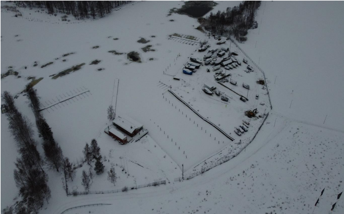
Kuva 1. Yleiskuva kohteesta. Kuvaussuunta idästä länteen.
