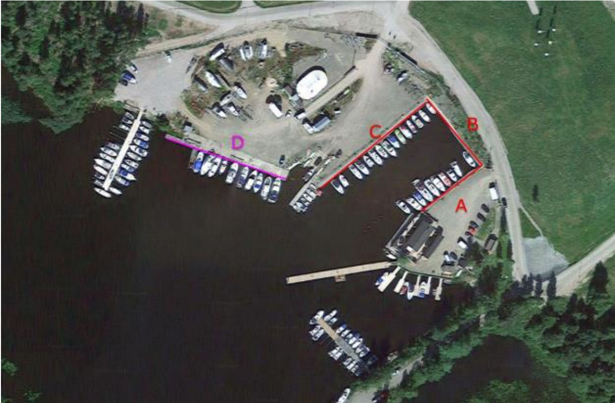
Kuva 3. Ilmakuva kohdealueesta. Venesataman saneerauksen urakka-alueet A, B, C ja D merkattu kuvaan. (FCG kuntotarkastusraportti 2018)
