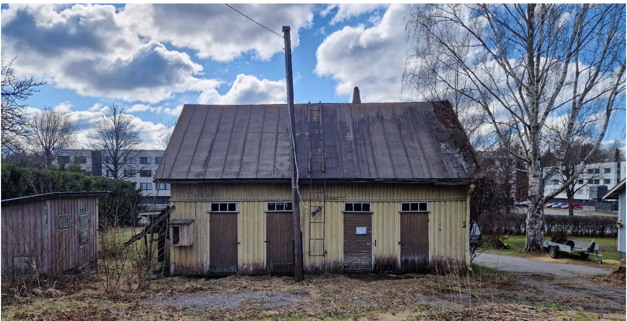
Kuva 26. Talousrakennuksen julkisivu luoteeseen.
