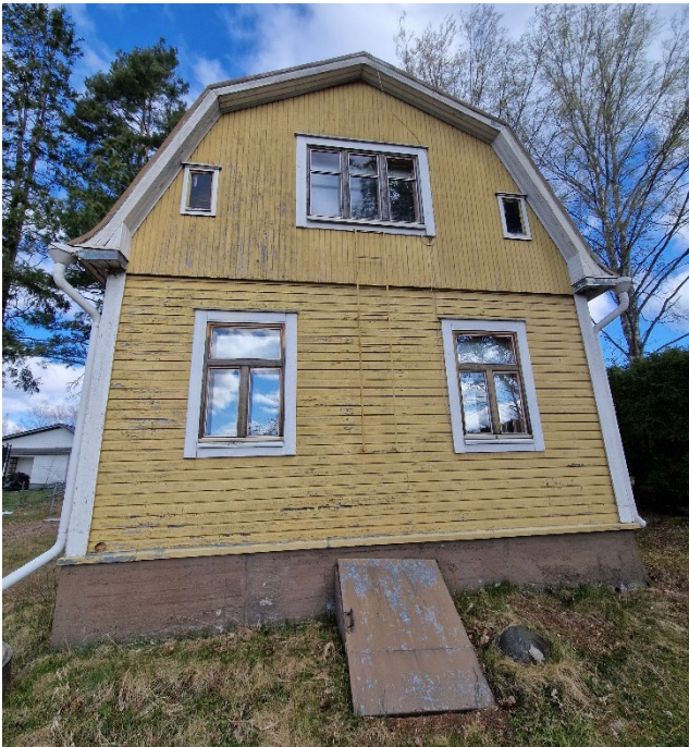
Kuva 21. (vasemmalla) Päärakennuksen kaakkoisjulkisivu.
