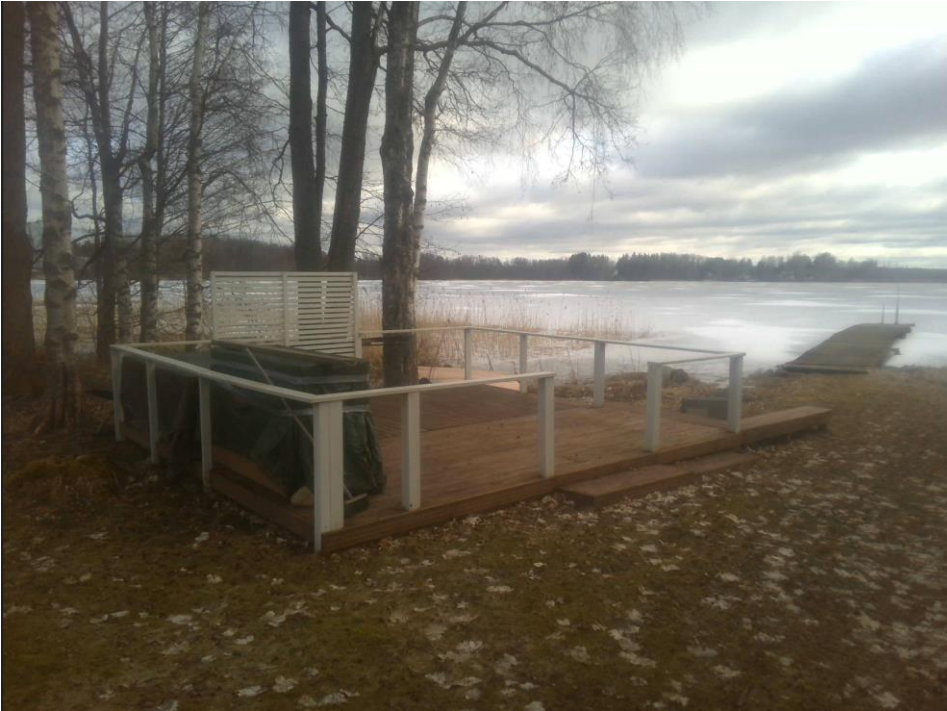
Kuva 8. Rannassa sijaitseva terassirakennelma.
