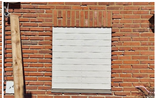
Kuva 78 (vasemmalla). Kaakkoisjulkisivun ikkuna. Ikkunat on kunnostettu tai uusittu oletettavasti vuonna 2014 käyttötarkoituksen muutoksen yhteydessä. Puitejako on pidetty alkuperäistä vastaavana.
