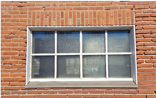
Kuva 78 (vasemmalla). Kaakkoisjulkisivun ikkuna. Ikkunat on kunnostettu tai uusittu oletettavasti vuonna 2014 käyttötarkoituksen muutoksen yhteydessä. Puitejako on pidetty alkuperäistä vastaavana.
