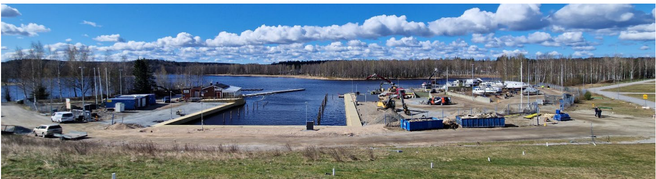
Kuva 87. Kuva entisen sahan paikalla olevalta pima-mäeltä kohti pumppuhuonetta ja entistä tukkiallasta.
