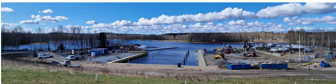
Kuva 48. Kuvassa vasemmalla pumppuhuone, keskellä tukkiallas ja oikealla muuta sataman aluetta. Kuva otettu vuonna 2026 peruskorjauksen ollessa vielä kesken.
