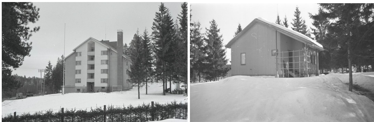
Kuva 16 (vasemmalla). OTK:n henkilökunnan asunnoiksi vuonna 1956 valmistunut kerrostalorakennus. Rakennus on yhä olemassa. Valokuvannut Olli Nieminen vuonna 1957. Kuvalähde: Työväenmuseo Werstas
