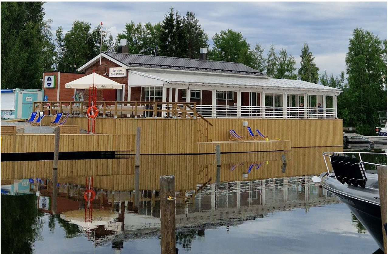
Kuva 69. Pumppuhuone pohjoisesta tukkialtaan puolelta kuvattuna.
