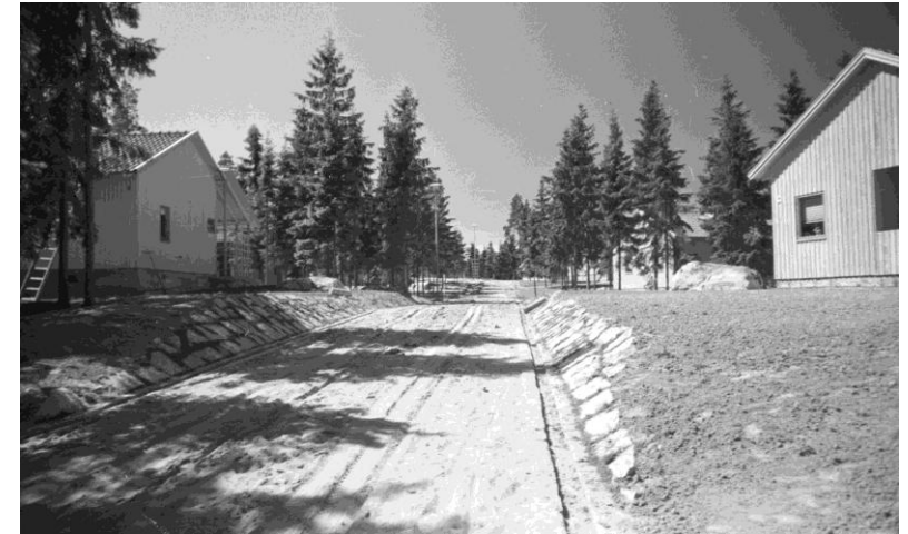
Kuusitielle rakennettuja henkilökunnan asuinrakennuksia 22.6.1946. Kuva Väinö Hyvärinen. Työväenmuseo Werstas.
