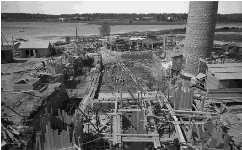
Sahan voimalaitoksen rakentumista 22.6.1945. Kuva Väinö Hyvärinen. Työväenmuseo Werstas.
