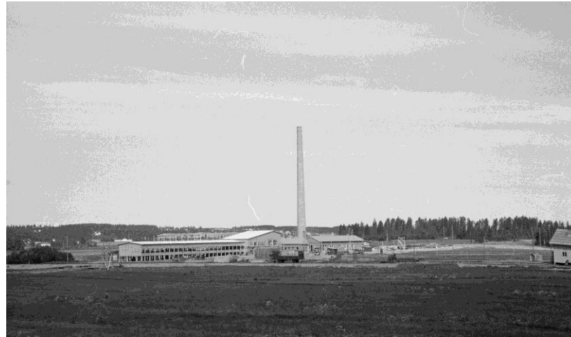
Yleiskuva OTK Puu Oy:n tehtaan rakentumisesta 22.6.1945. Kuva Väinö Hyvärinen. Työväenmuseo Werstas.
